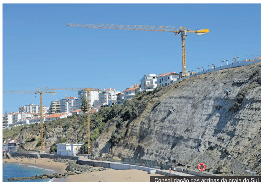
Consolidação das arribas da praia do Sul
