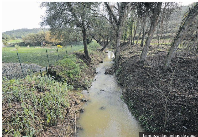
Limpeza das linhas de água
