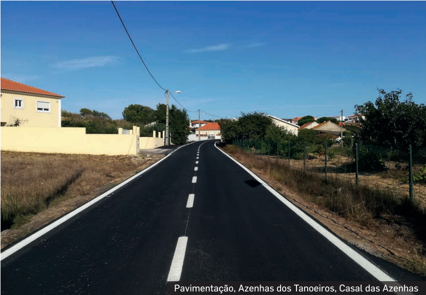
Pavimentação, Azenhas dos Tanoeiros, Casal das Azenhas
