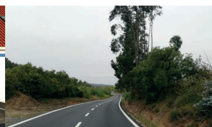
Pavimentação EM554, Picanceira/ Freiria
