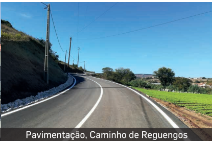
Pavimentação, Caminho de Reguengos
