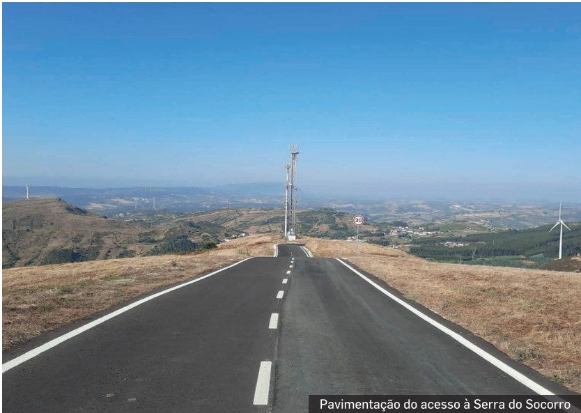
Pavimentação do acesso à Serra do Socorro
