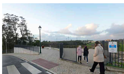
Pavimento pitonado nas passeadeiras
