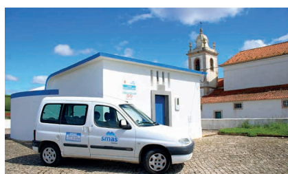
Manutenção de instalações
