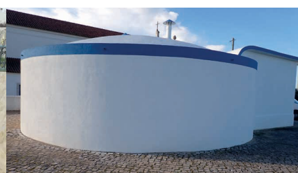
Manutenção de instalações
