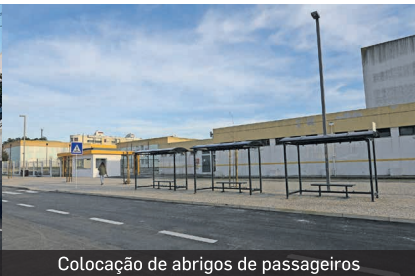
Colocação de abrigos de passageiros
