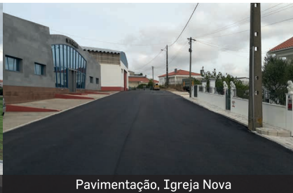
Pavimentação, Igreja Nova
