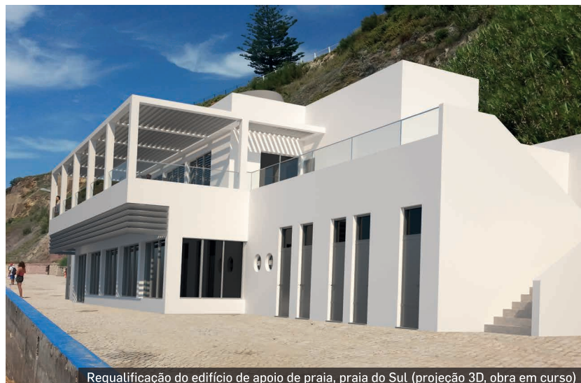
Requalificação do edifício de apoio de praia, praia do Sul (projeção 3D, obra em curso)
