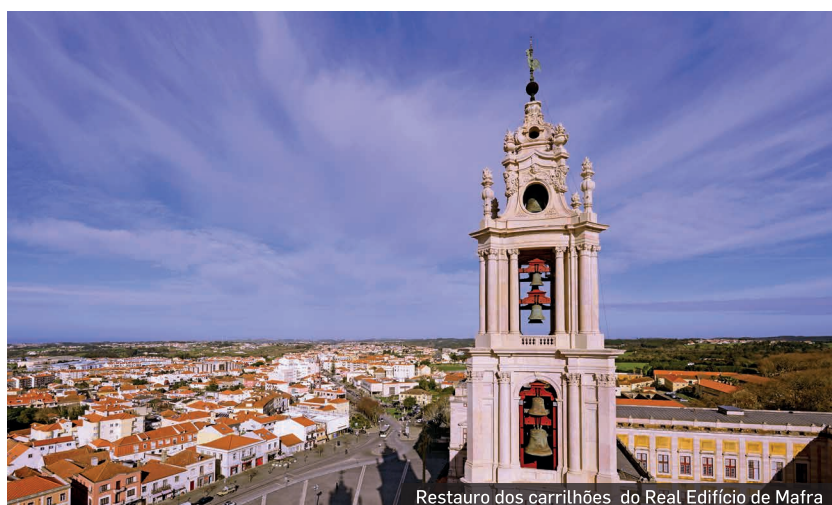
Restauro dos carrilhões do Real Edifício de Mafra
